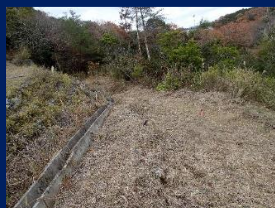
P4 斜面下部の状況
