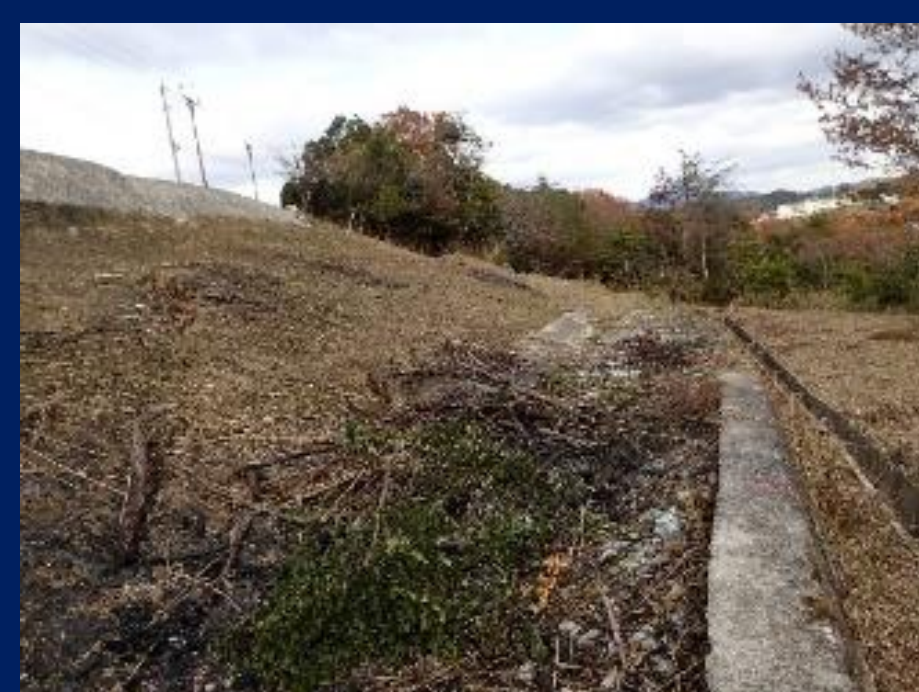
P3 斜面内の状況
